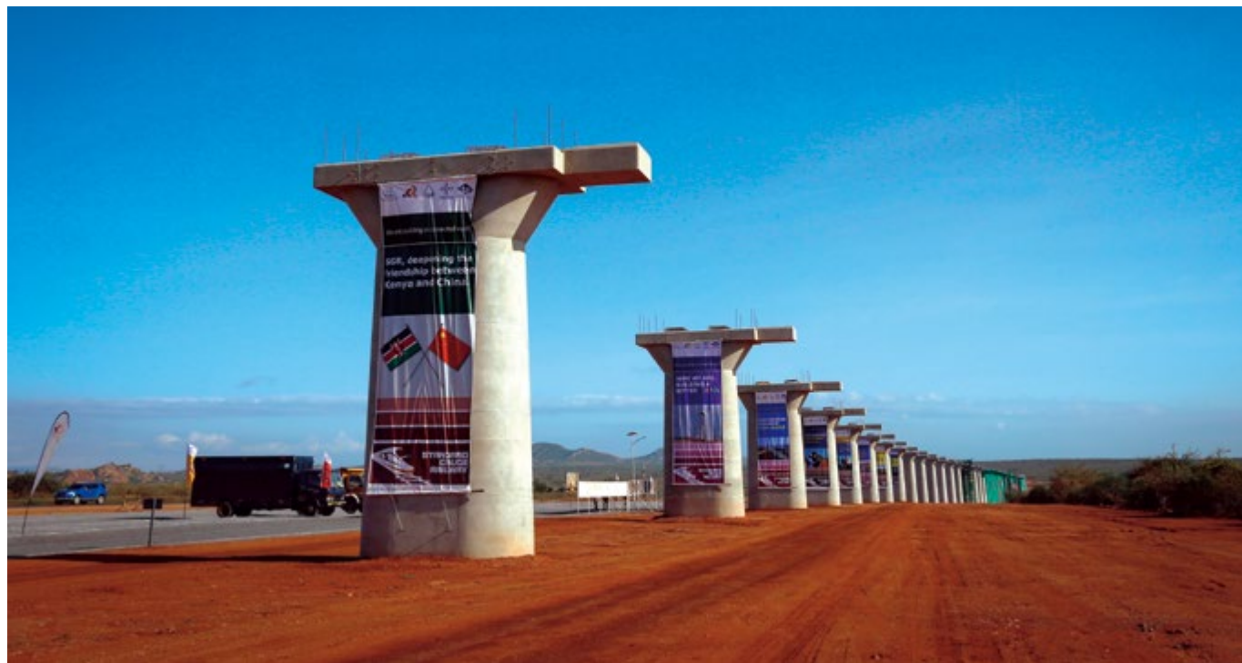
蒙巴萨到内罗毕铁路上的察沃河特大桥。该铁路项目由中国公司承建，未来将惠及肯尼亚民生。摄影/潘思危
