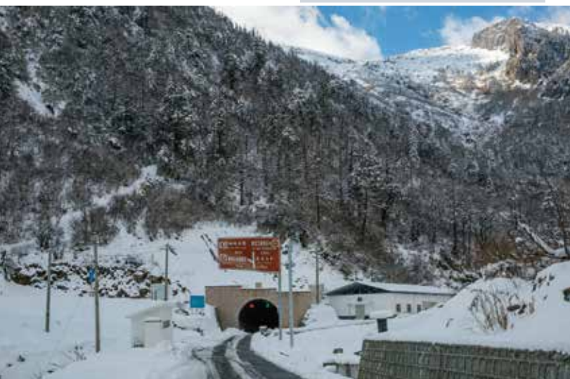
独龙江隧道。这里山势险峻、沟谷纵横、地质结构复杂、气候环境恶劣。独龙江乡曾经是我国唯一不通公路的少数民族聚居区。尽管于 1999 年内地至独龙江的公路修通了，但每年至少有半年以上的时间因大雪封山而阻断。为彻底解决这个问题，同时也最大限度地减少对高黎贡山自然保护区植被的破坏，新改建的公路修建了一条长达 6680 米的独龙江隧道，并于 2015 年正式通车。
