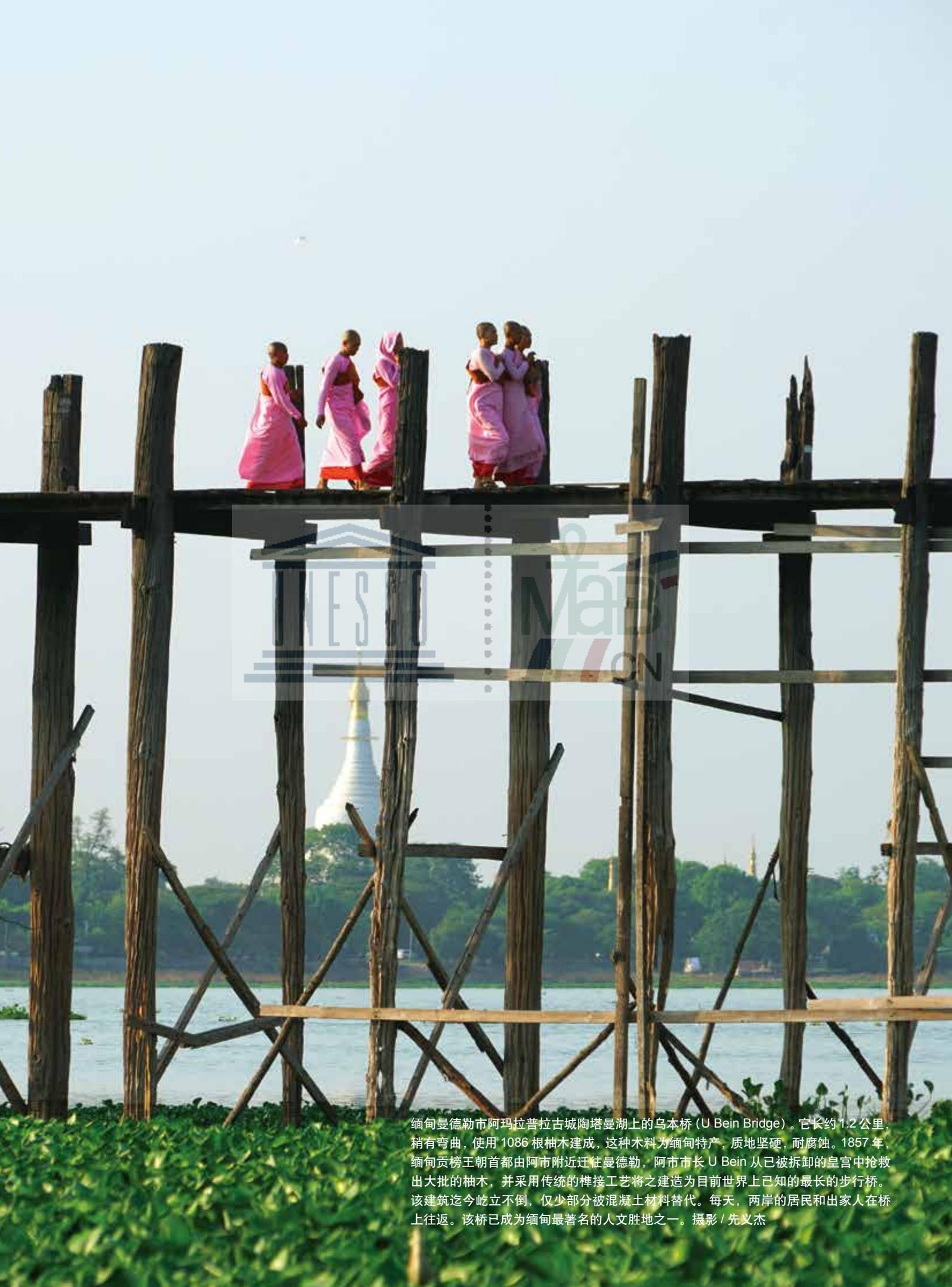
缅甸曼德勒市阿玛拉普拉古城陶塔曼湖上的乌本桥 (U Bein Bridge)。它长约 1.2 公里，稍有弯曲，使用 1086 根柚木建成，这种木料为缅甸特产，质地坚硬，耐腐蚀。1857 年，缅甸贡榜王朝首都由阿市附近迁往曼德勒，阿市市长 U Bein 从已被拆卸的皇宫中抢救出大批的柚木，并采用传统的榫接工艺将之建造为目前世界上已知的最长的步行桥。该建筑迄今屹立不倒，仅少部分被混凝土材料替代。每天，两岸的居民和出家人在桥上往返。该桥已成为缅甸最著名的人文胜地之一。摄影 / 先义杰
