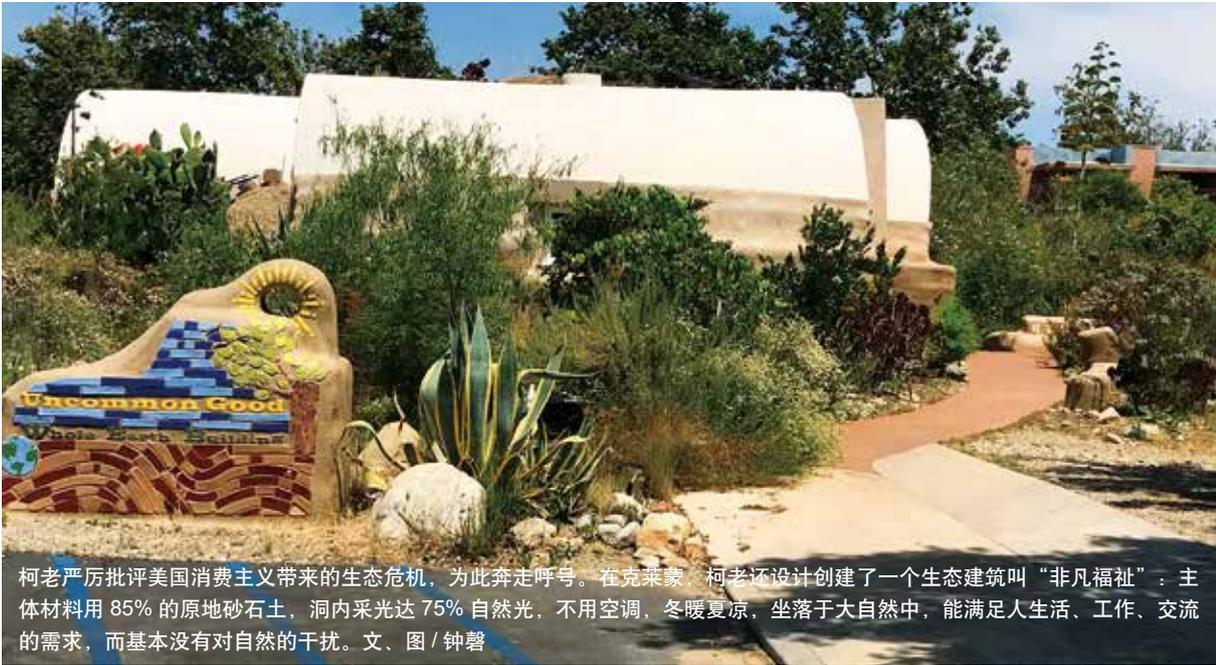
柯老严厉批评美国消费主义带来的生态危机，为此奔走呼号。在克莱蒙，柯老还设计创建了一个生态建筑叫“非凡福祉”：主体材料用 85% 的原地砂石土，洞内采光达 75% 自然光，不用空调，冬暖夏凉，坐落于大自然中，能满足人生活、工作、交流的需求，而基本没有对自然的干扰。文、图 / 钟馨
