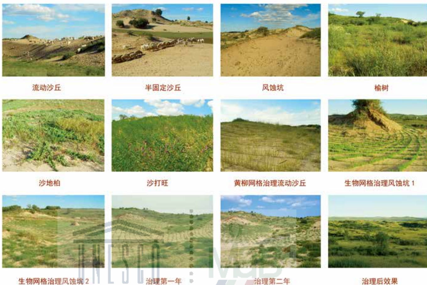
沙地治理“三分模式”与“生物网格治沙技术”的试验示范。示范区位于内蒙古站区后的浑善达克沙地，示范区面积 15000 亩。
