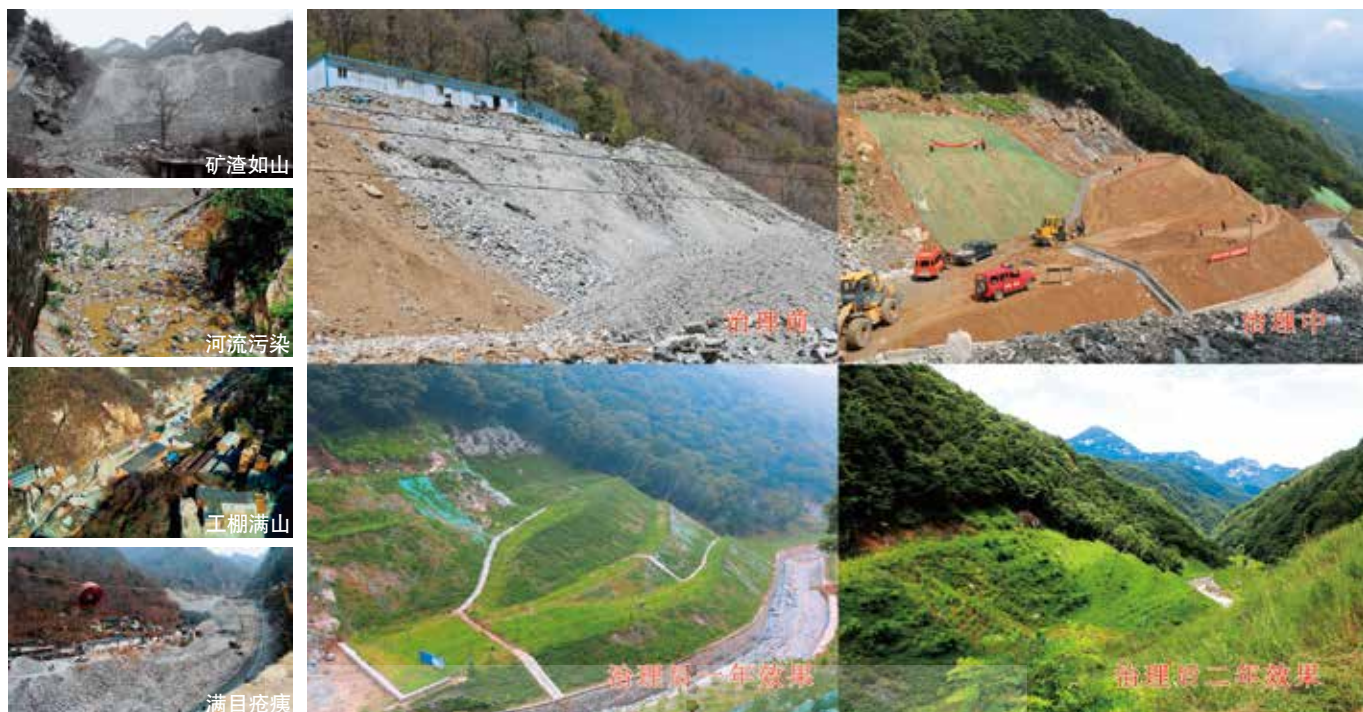
小秦岭保护区矿山环境整治和生态修复工作取得了显著成效，实现了复绿于山，修山予民。图为原老鸦盆金矿 1770 坑口通过治理和生态修复，原来如山的废矿渣重新披上绿装。供图 / 小秦岭保护区管理局
